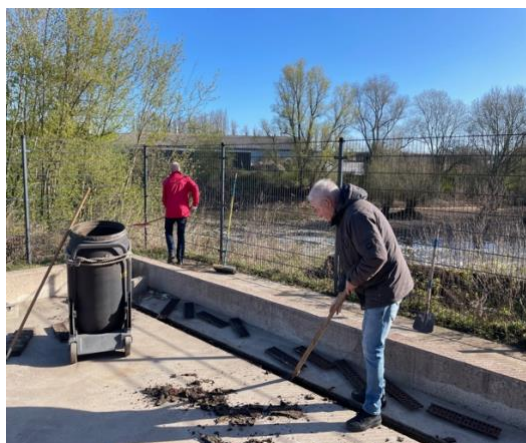
Reinigen van de goot van de afsputplaats
